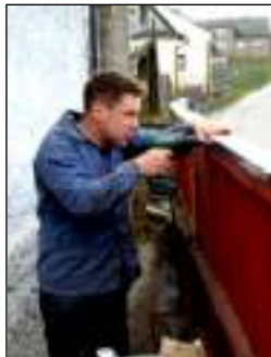
WABLAUTANAGA připevňuje na horní hranu plotu pozinkované plechy
